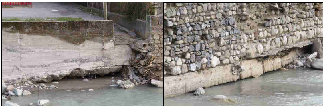
Foto n° 5: Ripresa fotografica del tratto di muro scalzato alla base in prossimità del Ponte San Giuseppe
