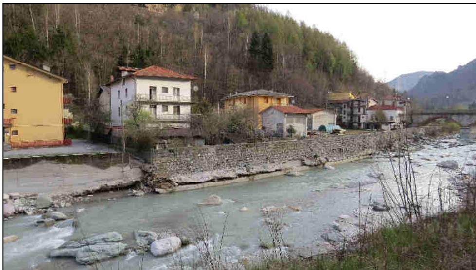
Foto n° 5: Ripresa fotografica del tratto di muro scalzato alla base in prossimità del Ponte San Giuseppe
