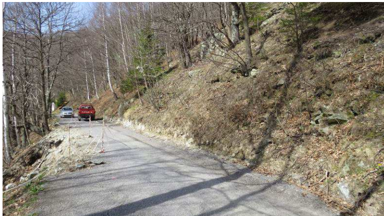
Foto n° 2: intervento n° 1, il dissesto è avvenuto a carico della banchina stradale con parziale coinvolgimento della carreggiata; l'intervento prevede l'allargamento della carreggiata con scavo e sostegno della scarpata di monte.
