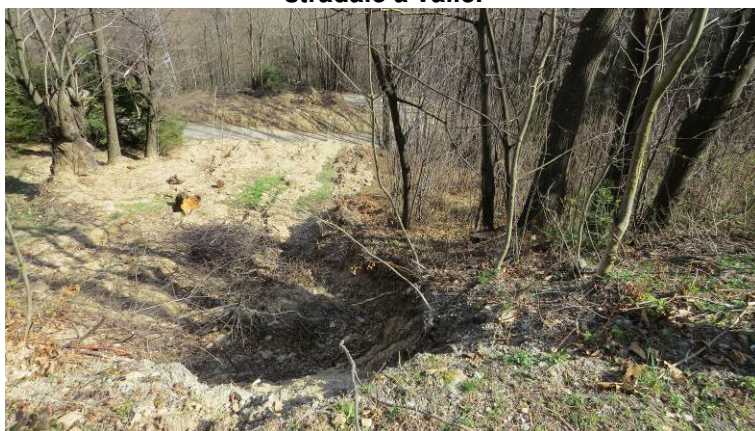
Foto n° 7: intervento n° 3, il dissesto è avvenuto a carico della scarpata di valle della strada, in prossimità di un tornante. Il materiale franato si è accumulato sulla sede stradale a valle.
