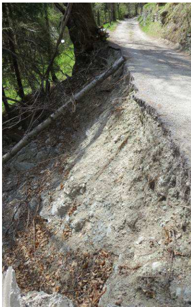
Foto n° 5: intervento n° 2, il dissesto è avvenuto a carico del muro di sostegno a valle della strada con parziale coinvolgimento della carreggiata; l'intervento prevede il ripristino dell'opera di sostegno.
