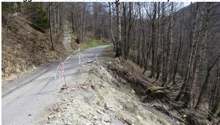
Foto n° 3: intervento n° 1, il dissesto è avvenuto a carico della banchina stradale con parziale coinvolgimento della carreggiata; l'intervento prevede l'allargamento della carreggiata con scavo e sostegno della scarpata di monte.
