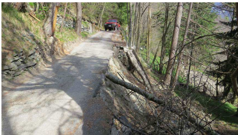
Foto n° 4: intervento n° 2, il dissesto è avvenuto a carico del muro di sostegno a valle della strada con parziale coinvolgimento della carreggiata; l'intervento prevede il ripristino dell'opera di sostegno.
